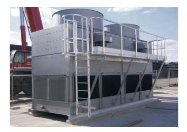
Bei der Nasskühlung wird das zu kühlende Wasser in der Luft versprüht. Die Luft wird erwärmt, was zu einem Kamineffekt führt, und das Wasser gibt seine Energie ab. Kühltürme mit Nasskühlung verfügen über eine sehr hohe Leistungsdichte. Der Wasserverlust bei der Verdampfung wird durch Tropfenabscheider minimiert.
